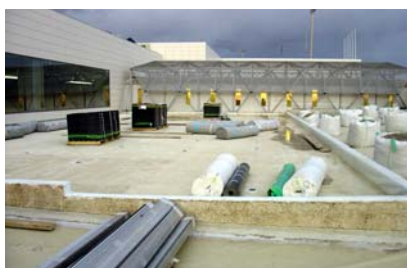
Se ven al fondo las mantas protectoras, los elementos Floradrain® FD 40 y el filtro.
