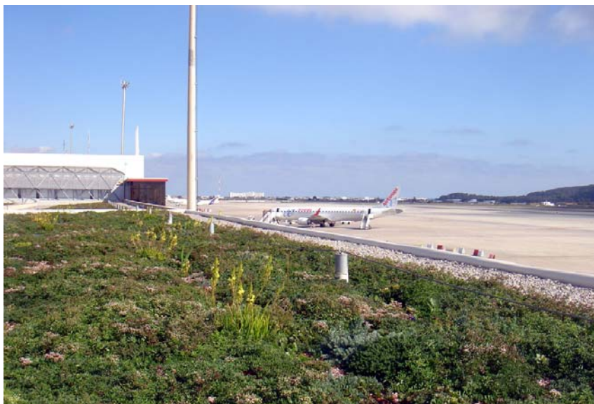
Vista parcial de la cubierta con la plantación de tipo extensiva.
