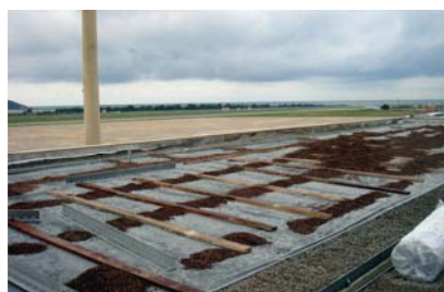
Sistema lastrado preparado para la colocación del sustrato con Turbo-bag.
