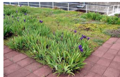
Para poder enseñar el techo verde a los visitantes, se ha previsto incluso una superficie con vegetación a modo de terraza.
