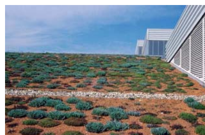
Sedums en crecimiento. Se puede ver la franja de grava transversal, dentro de la zona de riego.
