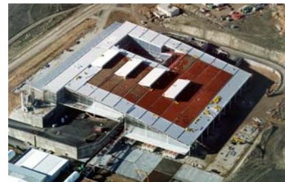
Toma de aire del sistema de reciclaje en Vertresa.
