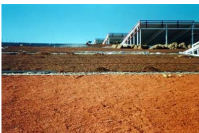
El Zincolit esparcido, cubierto con tejido anti-erosión en yute y compost Zincohum.
